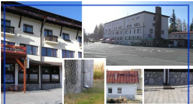
Odkanalizovanie dažďovej vody zo striech
