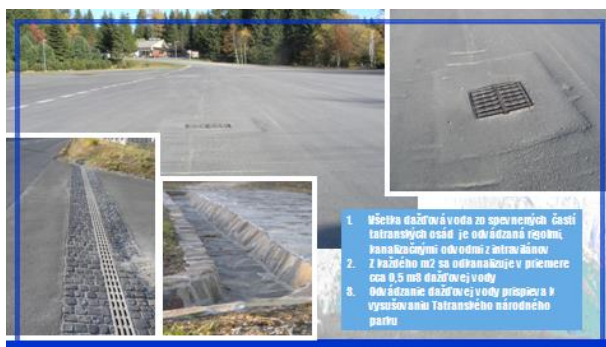
Spôsob odvádzania dažďovej vody zo spevnených plôch
