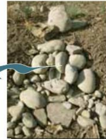
Kameňmi vydláždený vstup. Kamene by mali byť bez usadenín (dôkladne umyté)
