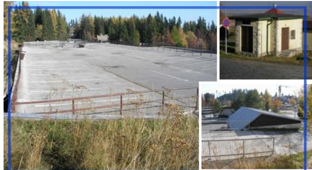
Všetky strechy sú odvodnené odkvapovými rúrami
