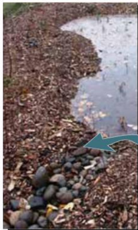
Kameňmi vydláždený odtok
