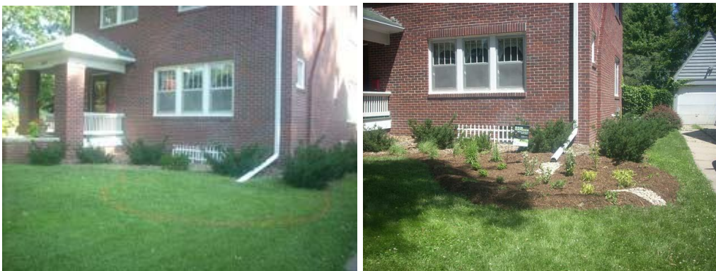
Obr.: Realizácia dažďovej záhrady k rodinnému domu. Foto ukazuje stav pred a po 43
