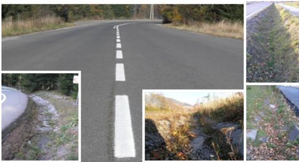
Cesta slobody po celej dĺžke je odkanalizovaná rigolmi
